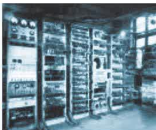
Mark I, le premier ordinateur électronique fabriqué à l'Université de Pennsylvanie. Il fait 30 tonnes, occupe 160m 2 et sa mémoire est constituée de 18 000 tubes à vide.
